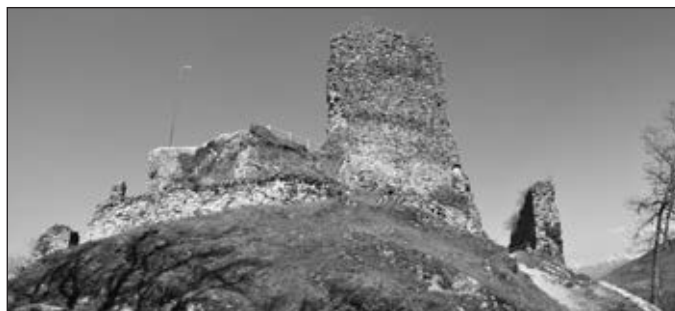
Figure 14 : Front d'attaque sud-ouest de Château-Vieux et mur bouclier. (Cliché : L. D'Agostino, HADES)
