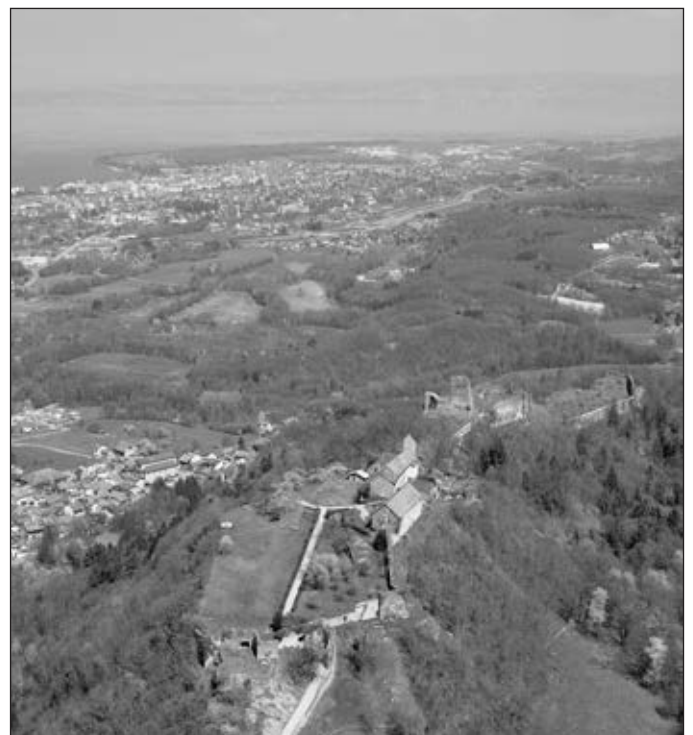
Figure 12 : Vue aérienne des châteaux d'Allinges, Château-Neuf au premier plan, Château-Vieux au deuxième plan. (Cliché : L. D'Agostino, HADES)
